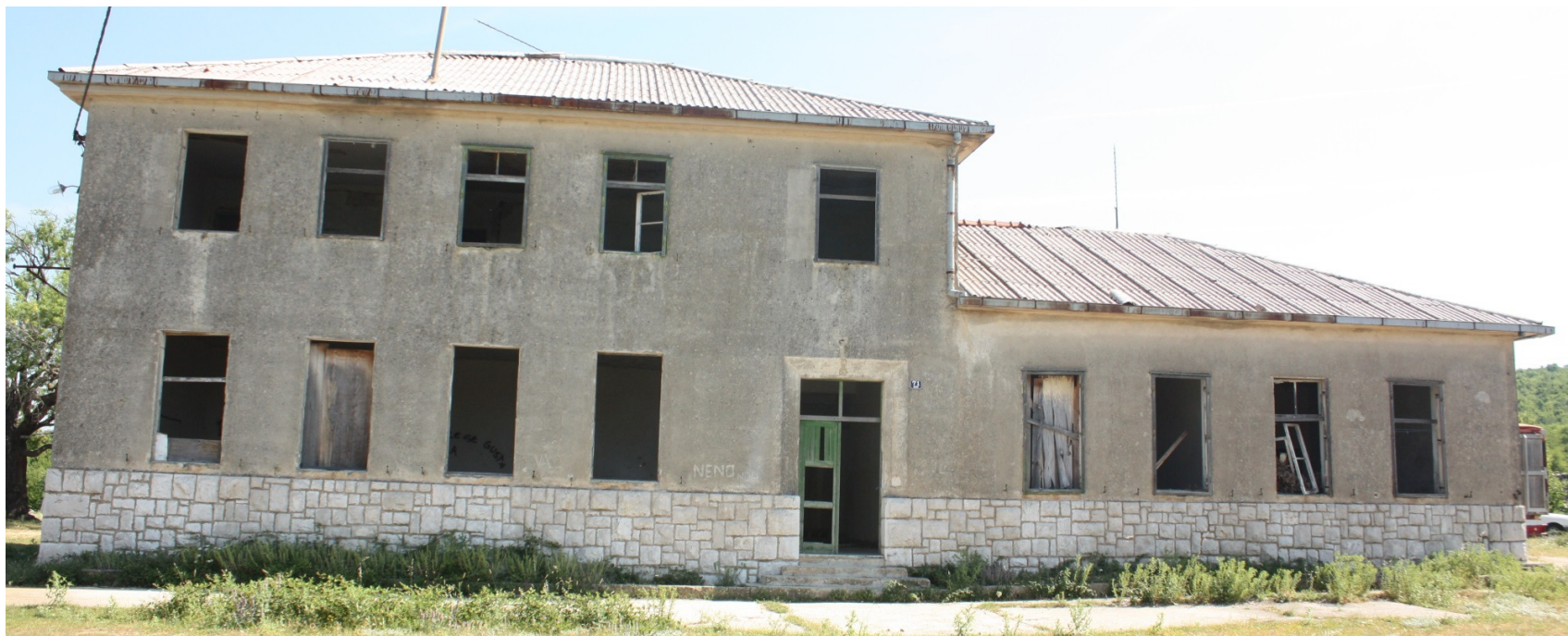
Slika 11. Zgrada škole u Kladnjicama
